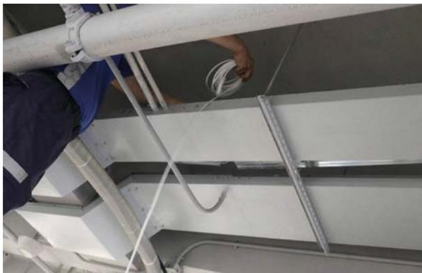
步骤 4 光电复合缆从桥架中穿出时，使用 PVC 软管保护，避免线缆裸露受损。将 PVC 软管固定在相邻支架上。
