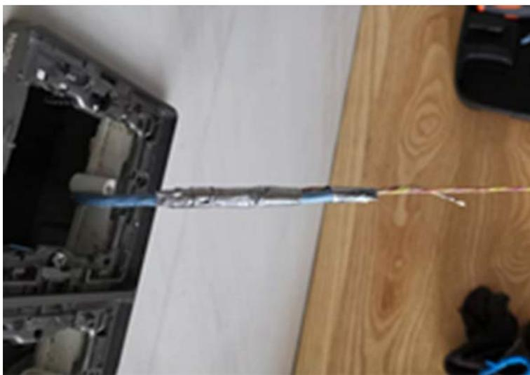
步骤 4 往暗管入口，倒入适量线缆润滑剂，并佩戴好手套。
